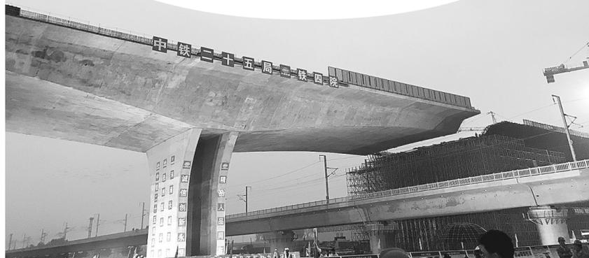
本报讯(记者 聂春浩 张倩)通讯员 杨宇 王云海 文/图)10月22日15点58分,总长99.5米、宽45.83米、重2万吨的T型梁体——迎宾大道上跨郑万高铁转体立交工程开始实施转体。历时1时59分,于当天17点57分成功跨越郑万高铁,将郑州机场与郑州南站进行连接。据了解,双向8车道45.83米宽幅桥梁跨高铁转体,在世界上尚属首次。
