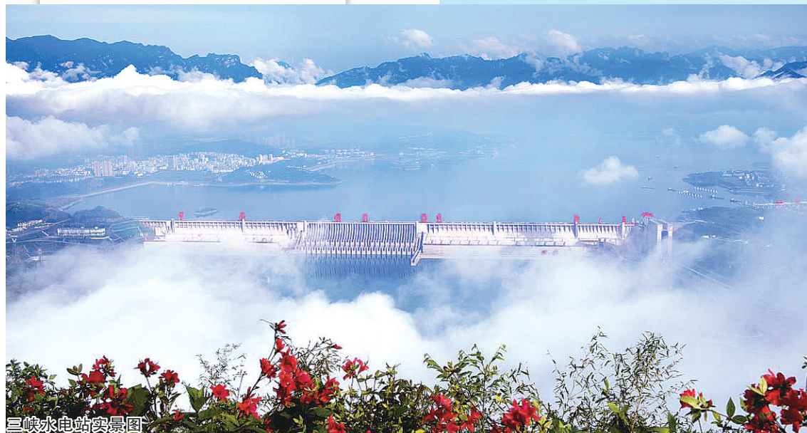
三峡水电站实景图
