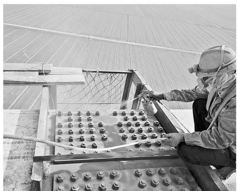
工人在郑州黄河特大桥上进行螺栓施工
