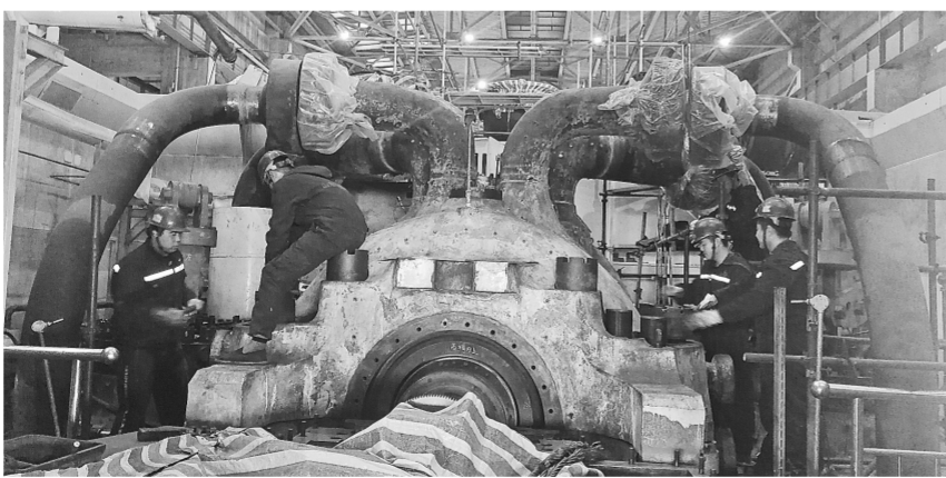
工作人员加班加点施工
