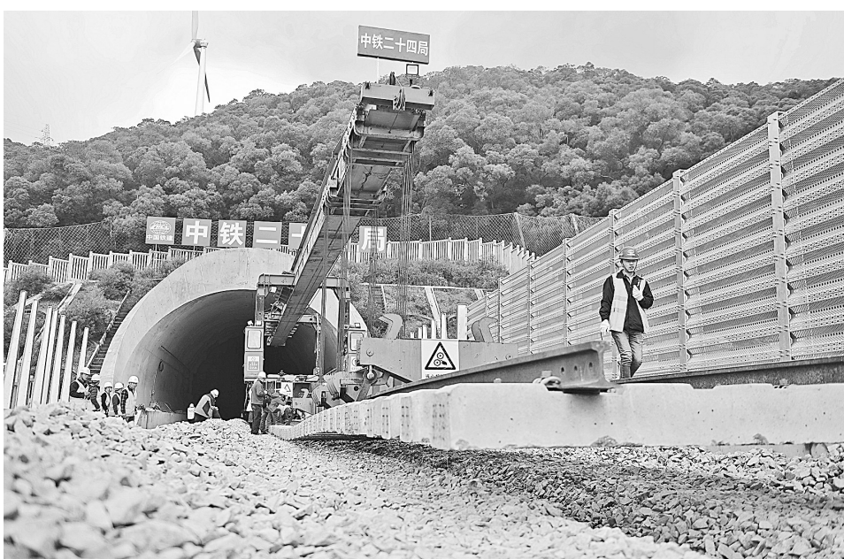
12月22日,中铁二十四局工作人员在平潭海峡公铁大桥铺轨施工现场进行铺轨作业。当日,总长为16.34公里的福平铁路平潭海峡公铁大桥铺轨正式启动。平潭海峡公铁大桥是福州至平潭铁路控制性工程,上层设计为时速100公里的六车道高速公路,下层为设计时速200公里的高铁,大桥计划2020年正式通车。新华社记者林善传摄
