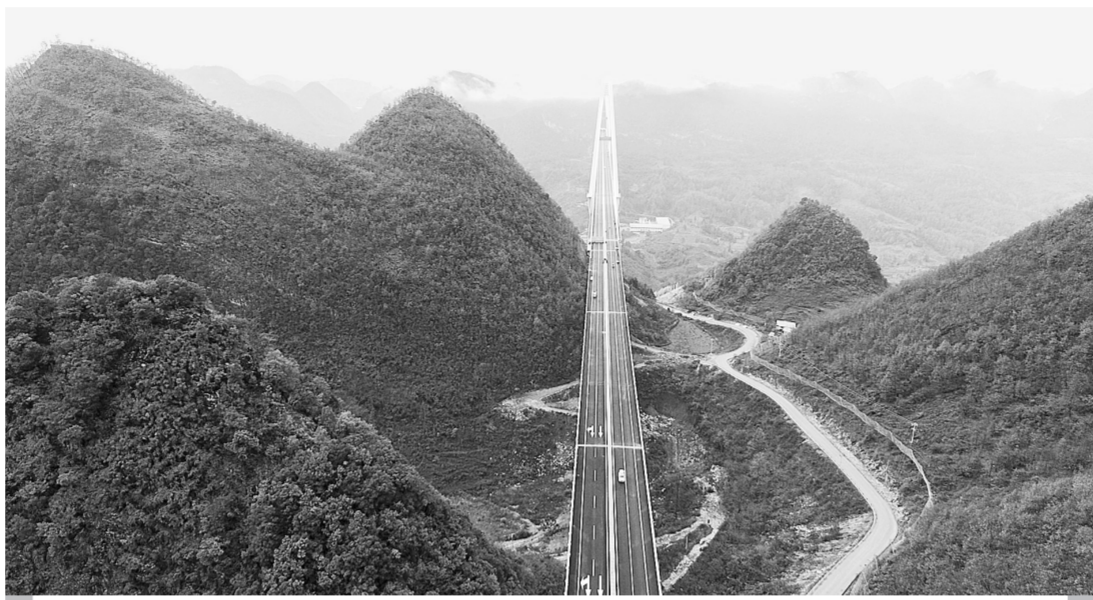
12月30日拍摄的贵州平塘特大桥(无人机照片)。当日,贵州省平塘至罗甸高速公路建成通车,这也标志着作为该段高速公路控制性工程的平塘特大桥正式建成通车。平塘特大桥横跨峡谷,连接罗甸、平塘两县,全长2135米,总投资约15亿元。平塘特大桥通车后,平塘到罗甸的通行时间从2个半小时缩短至1小时,将成为连接贵州南部的交通要道。 新华社记者 杨文斌 摄
