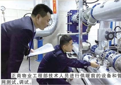
正商物业工程部技术人员进行供暖前的设备和管网测试、调试。
