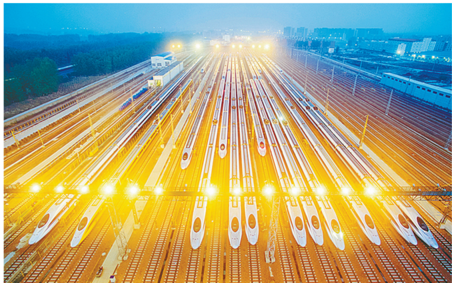
郑州是全国12个最高等级的国际性综合交通枢纽之一,是目前全国唯一一座高铁“米”字形枢纽,在全国铁路运输中具有重要战略地位,被称为“中国铁路心脏”。图为郑州动车编组站魅力夜景。 焦满翔 摄
