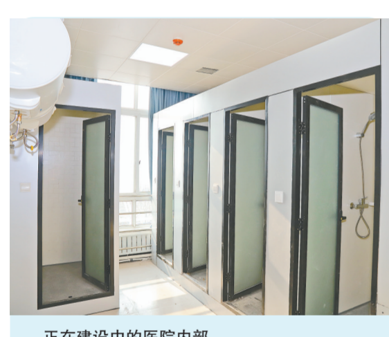
正在建设中的医院内部
