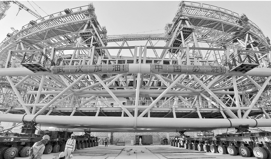
2月16日,在卡塔尔多哈,张贴着“武汉加油!中国必胜!”横幅的合龙段压环吊装升空,并迅速就位合龙,标志着中国铁建国际集团(中铁建)承建的卡塔尔2022年世界杯足球赛主体育场项目主体结构施工完成,“马鞍形”外观成型。图为张贴着“武汉加油!中国必胜!”横幅的合龙段压环(2月16日摄)。
