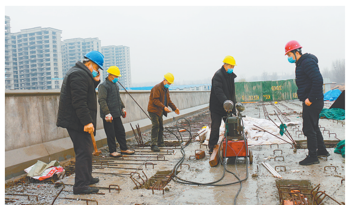
昨日，由中铁四局一公司承建的郑州市迎宾路项目在雨中复工，拉开了我市交通建设行业复工帷幕。
