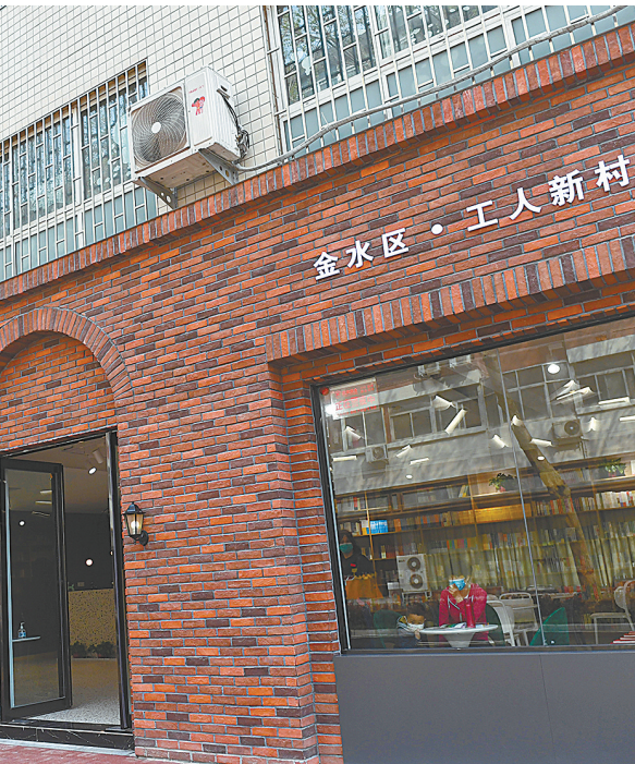
金水区工人新村沿街门面焕然一新
