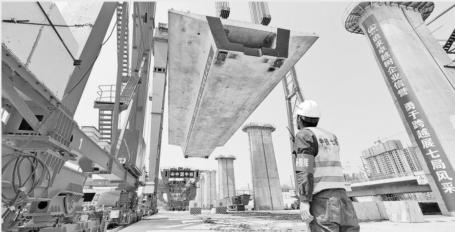
本报讯(记者 张倩 通讯员 姬妮生 赵亚龙 文图)“驾驶员、驾驶员,吊钩全部检查完毕,安全,开始起吊!”昨日11时,随着现场吊梁总指挥一声令下,中铁七局郑州公司为郑济铁路“私人订制”的高铁提梁机正式开始提梁作业,随着梁体的缓缓升起,正式拉开了郑济铁路郑州境内首片双线铁路箱梁架梁施工的序幕。
