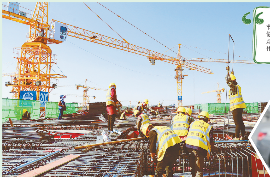
为抢回因疫情滞后的20天工期,五一劳动节期间郑州南站项目1400多名建设者放弃假期,坚守施工一线,加班加点抢进度 郑报全媒体记者 马健 摄
