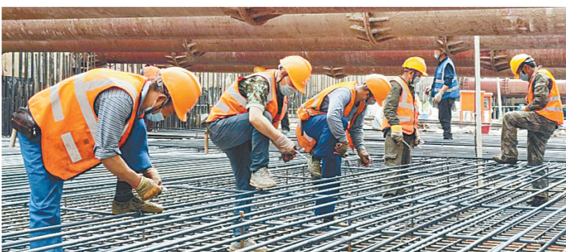
施工现场,工人在绑扎钢筋
