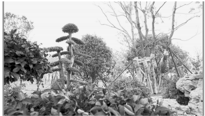
御风公园建设现场,绿化工程正在有序推进中。
