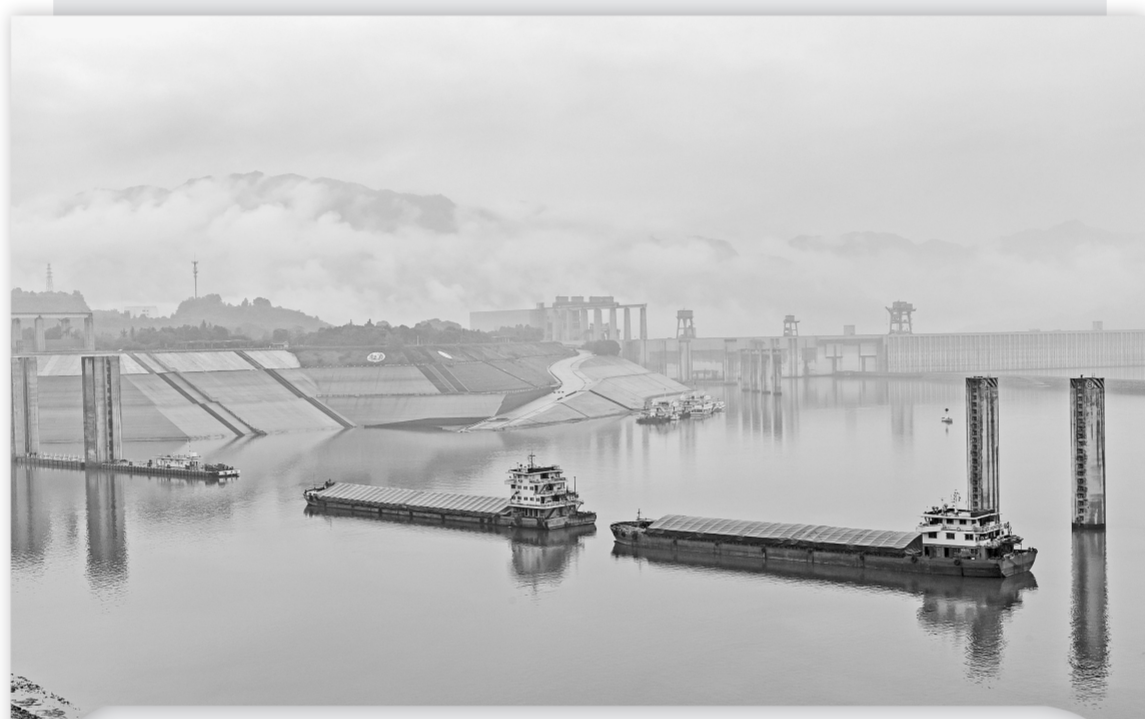
6月9日，船舶有序通过三峡大坝上游引航道。
