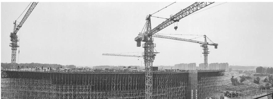
本报讯(记者 张倩 通讯员 王云海 尹运发 文/图)昨日上午,由铁四院设计、中铁二十五局二公司承建的航空港迎宾大道关键控制性工程——跨机(新郑机场)南(郑州南站)城际铁路转体桥梁主体已全部浇筑完工,为下一步的转体施工奠定坚实基础。
