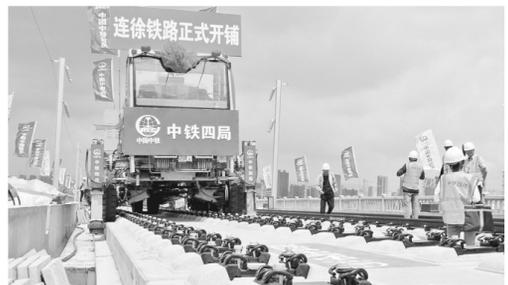
6月28日,工人在连徐高铁连云港站铺轨现场作业。当日,连接江苏连云港和徐州的连徐高铁正式开始铺轨。连徐高铁正线全长约180公里,设计时速350公里,预计年底具备通车条件,通车后乘坐高铁由连云港至徐州只需40分钟。新华社发
