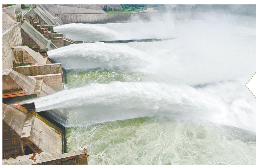
这是7月1日拍摄的黄河小浪底洪水调度运用、水库泄洪的场景(无人机照片)。
