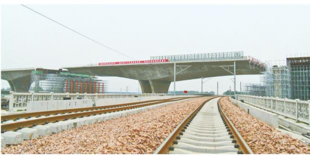
现跨铁路转体。其中,该段跨郑万高铁转体桥是世界上跨高铁最宽的转体桥,已于去年10月成功转体并合龙。
