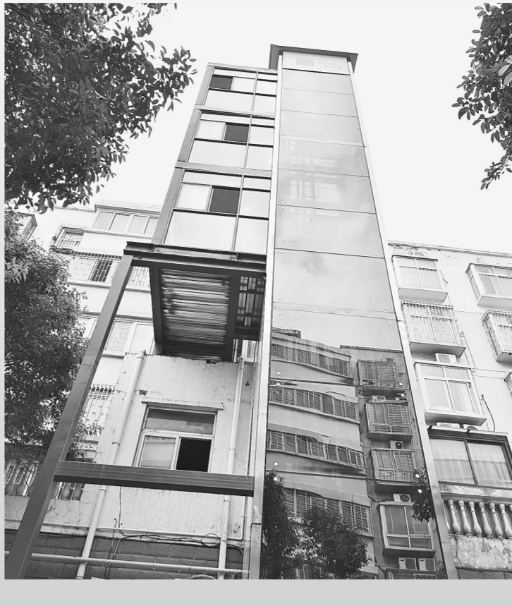
二七区兴华南街168号院加装的电梯 本报记者 丁友明 摄
