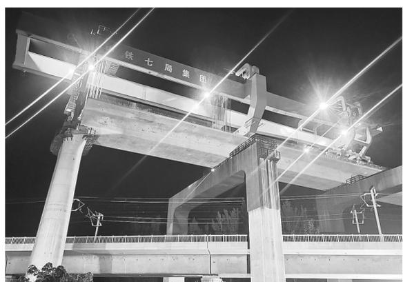
采用“钢横梁+简支箱梁”形式上跨高速铁路施工,有效节约了施工时间和经济成本(常规上跨既有铁路一般均采用转体或连续梁施工,施工时间较长、经济成本较高)。
