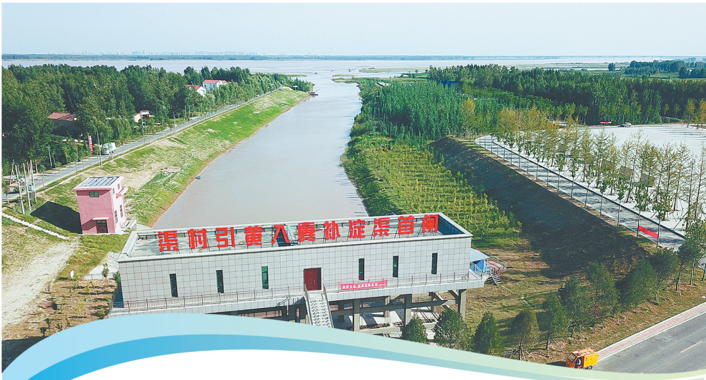
渠村引黄入冀补淀工程渠首闸
