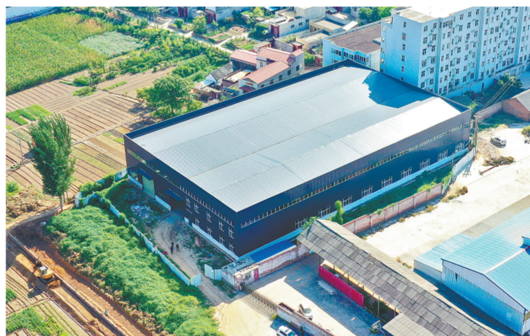
搬迁出黄河滩区后的新建厂房即将投入使用
