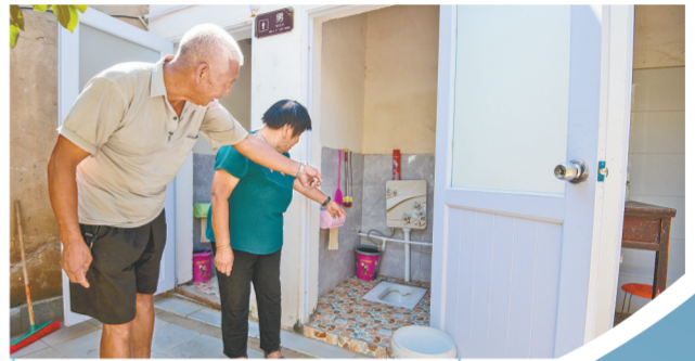
中牟县七里店村自来水、天然气安装完毕，提高了居民生活质量
