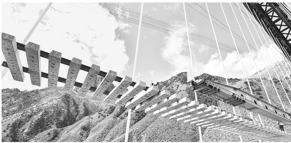
9月20日，伴随着阵阵轰鸣声，铺轨机吊着一排25米长的轨排，缓缓落在藏木雅鲁藏布江特大桥上，标志着拉萨至林芝铁路第三座跨越雅鲁藏布江特大桥已经铺轨，至此正线铺轨168公里，距离2021年建成通车更近了一步。拉萨至
