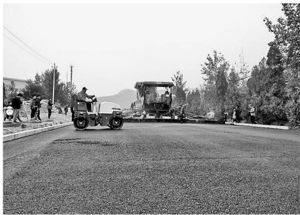
本报讯(记者 李晓光 通讯员 杜帅武/图)昨日上午,在登封环嵩山旅游公路建设嵩阳书院西路段,大型摊铺机轰鸣前行,重型双钢轮压路机来回碾压,一段宽15米、冒着热气的沥青路面出现在眼前。项目建设方郑州嵩岳公路开发有限公司总工程师常天冰介绍,现在的施工场面是在进行沥青的摊铺和碾压,10月底沥青路面摊铺结束后将进入道路附属工程建设,标志、标线、路灯、绿化等施工同时推进。
