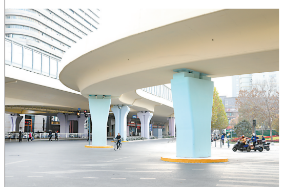
经三路农业路金水彩虹立交桥
