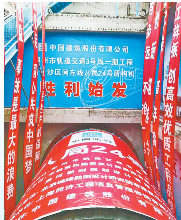
3号线一期工程新柳路站—沙门路站区间盾构始发
