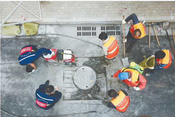
市政工人对路面进行养护
