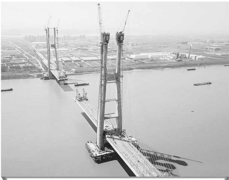
3月25日拍摄的安九(安庆至九江)铁路鳊鱼洲长江大桥。当日,安九铁路鳊鱼洲长江大桥主桥北主塔封顶,至此,大桥主桥两个主塔全部封顶。安九铁路鳊鱼洲长江大桥主桥主塔设计为H形结构,其中北主塔高252米;南主塔高242米,已于2020年12月30日封顶。
