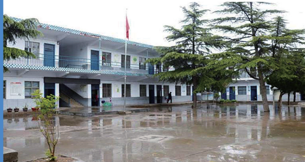
申泰集团援建的伊川县富留店小学校园
