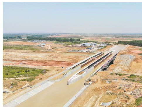
5月1日,由中铁四局、中铁建大桥局负责施工的引江济淮河总干渠渡槽充水试验成功,正式通水通航。渡槽总长350米,其中钢结构渡槽246米,主跨跨度达到110米,是目前世界上跨度最大的通航通航钢渡槽,也是引江济淮工程重要节点性工程。据了解,淮河总干渠引江济淮航道高出30多米,通过架设渡槽,引江水从引江济淮运河“跨过”,形成一座“河上有河”可通航行船的“水桥”。图为通水后的引江济淮河总干渠渡槽。新华社记者 周牧 摄
