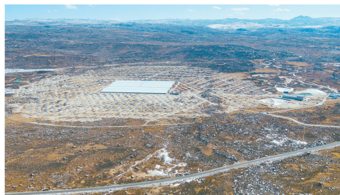
高海拔宇宙线观测站全景(无人拍照,2021年2月2日摄)。
