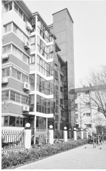
桐柏路191号院加装的电梯
