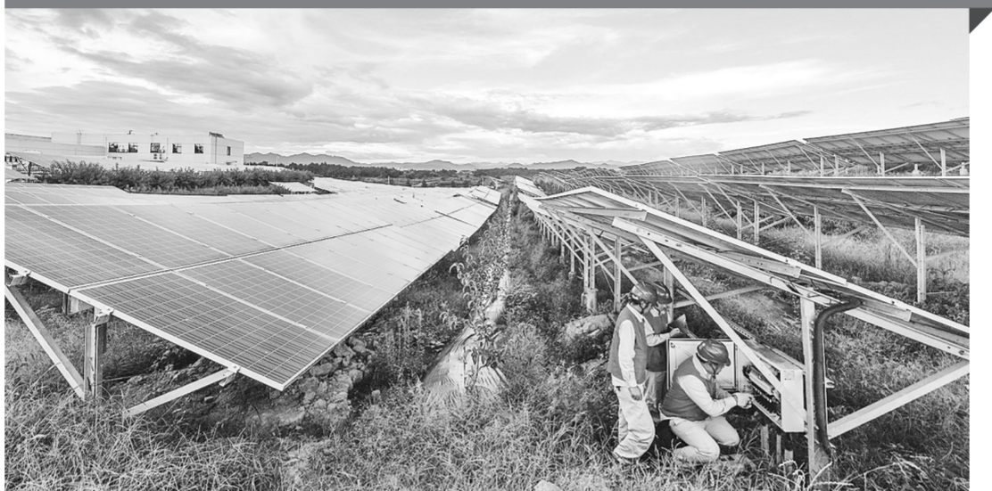
7月6日,工作人员巡查位于东阳市六石街道夏溪潭村附近的50兆瓦农光互补光伏发电项目。该项目总投资3.7亿元,占地面积约1700亩,年发电量2500万千瓦时。该项目在不改变原有土地性质、基本不改变原有地貌前提下,优化种植条件和植被类型,上方光伏板发电,下方种植喜阴经济作物,达到光伏发电与周边环境一体化完美结合。据介绍,东阳市规模化的光伏项目年均发电量4000万千瓦时,每年减少二氧化碳排放3万吨,通过电网将清洁能源送入千家万户。
