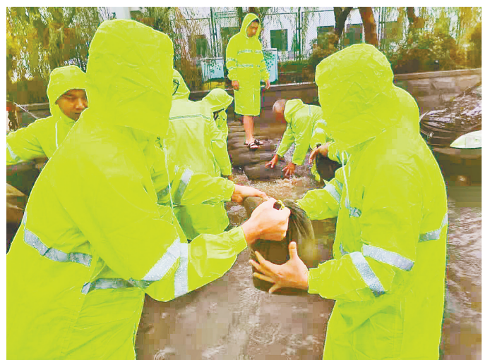
20日上午,针对第八大街经北六路李南岗积水严重的汛情,经开区综合行政执法局组织南湖办事处执法中队紧急调运防汛物资,筑起10米人墙接力运送沙袋,争分夺秒对道路低洼进行加高。本报记者 王译博 摄
