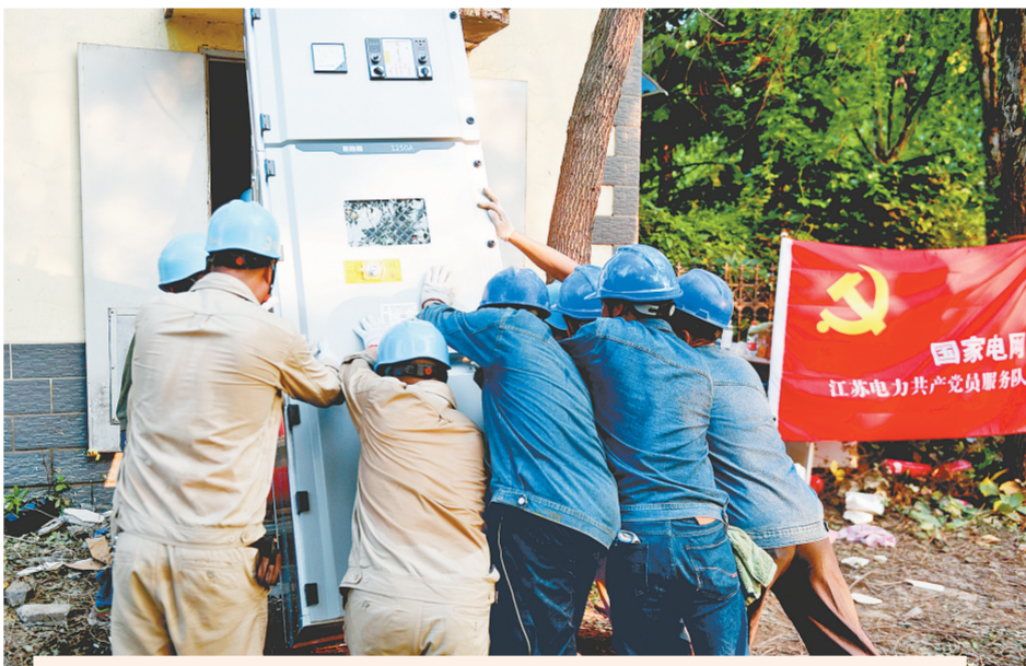
7月25日下午,江苏电力苏州公司共产党员服务队,在郑东新区龙子湖高校园区抢修电力设备,竭尽全力恢复附近高校和居民家中的电力供应。 郑报全媒体记者 周雨 摄
