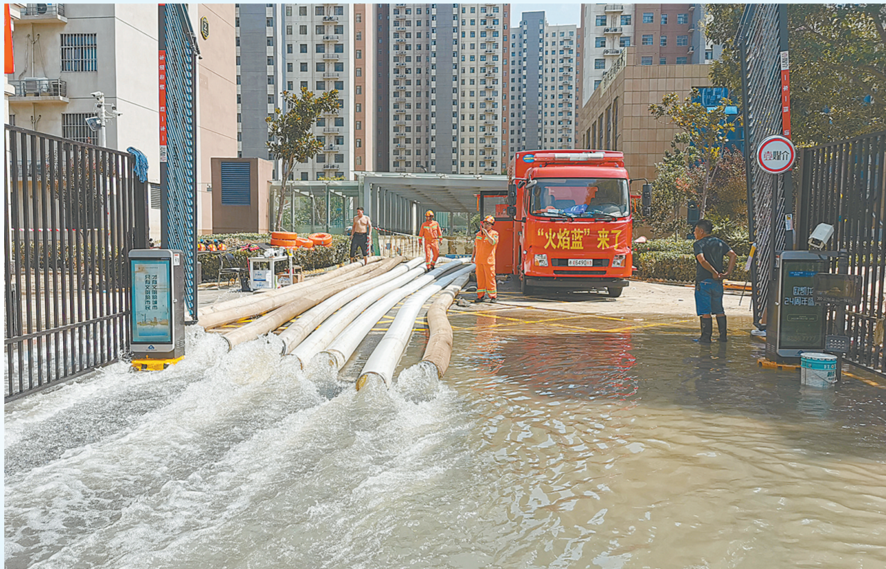
救援人员冒高温、战酷暑加紧为小区地下室抽积水
