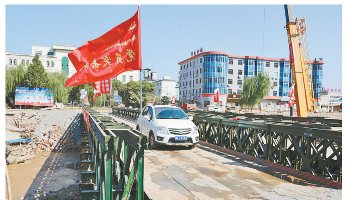
7月31日,巩义市米河镇小里河钢便桥正式通车,为米河灾后恢复重建提供有力支撑。本报记者 张倩 摄
