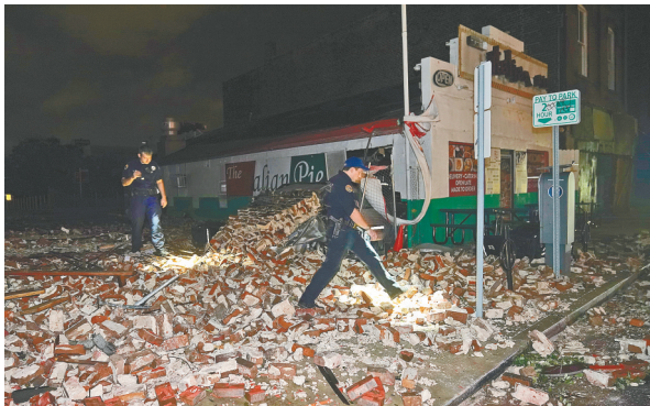
8月30日，在美国路易斯安那州新奥尔良，警察查看一处受飓风袭击而倒塌的建筑。
