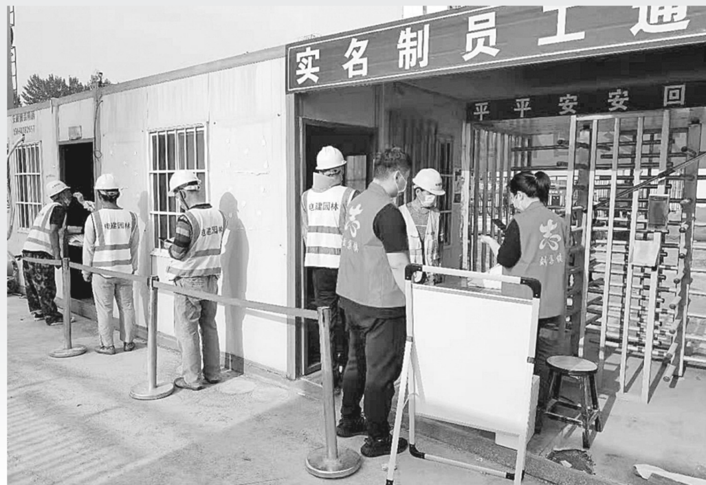
核酸检测点搬到工地上
