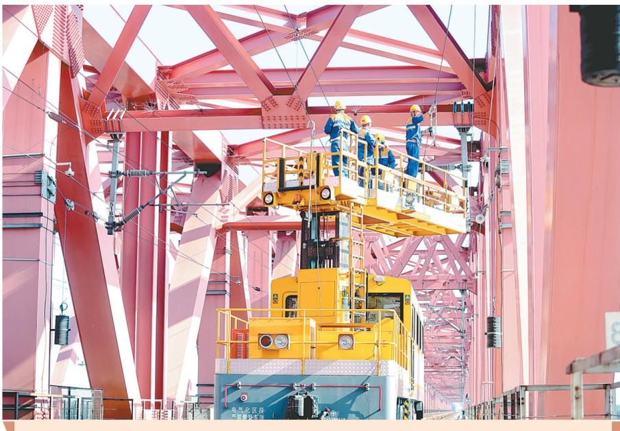
中铁郑州局郑州北供电车间近日积极开展京广线二阶段集中修作业,利用3天时间6个“天窗”点,对管内京广线黄河桥接触网设备进行全面检查。
