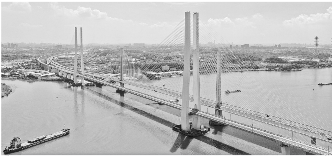
9月15日拍摄的完成左线铺轨的广州南沙港铁路跨西江特大斜拉桥。该桥为粤港澳大湾区基础设施“硬联通”重点工程，位于广东佛山市和江门市交界处，全长1117.5米。
