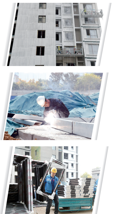
佳源·名门橙邦工程技术人员在工地现场精心施工,打造精品名筑。
