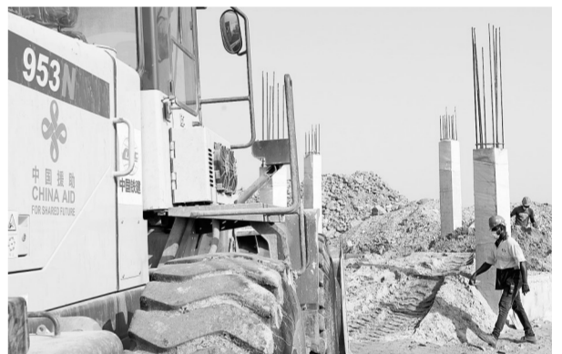
近日,在加纳首都阿克拉,工人在中国援建加纳渔港综合设施项目施工现场作业。该项目2020年8月开工,预计2023年2月完工,建成后极大改善当地渔民的工作和生活环境。目前项目施工进度顺利。新华社记者 许正摄
