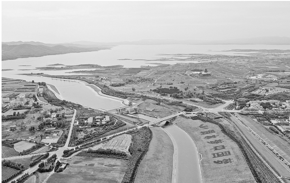
5月20日在河南省南阳市淅川县拍摄的南水北调中线工程陶岔渠首(无人机照片) 新华社记者 李嘉南 摄
