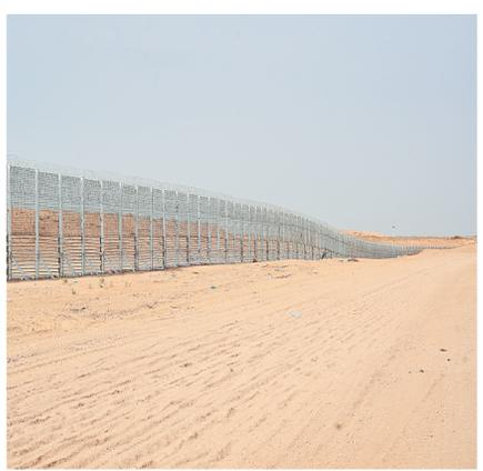
这是12月7日拍摄的以色列沿加沙地带“智能”隔离墙。以色列国防部7日宣布,经过3年多施工,沿巴勒斯坦加沙地带的“智能”隔离墙修建完成。该“智能”隔离墙全长65公里,分为地上和地下两部分,沿隔离墙安装有数百个摄像头、雷达系统和传感设备。隔离墙还延伸至海上,配备有侦测海上越境人员的系统和远程控制的武器系统。新华社发
