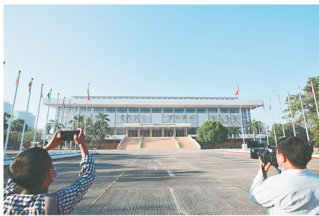
这是12月14日在缅甸仰光拍摄的缅甸国家体育馆外景。中国政府援助缅甸国家体育馆维修改造项目交接仪式14日在缅甸仰光举行。缅甸国家体育馆1986年竣工并投入使用,占地6.95公顷,总建筑面积2.6万平方米。维修改造项目开工仪式2019年8月举行。该项目对室内外装修、机电设备、灯光音响等进行了升级改造。 新华社发
